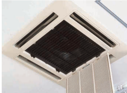
② 外蓋が開いた状態 中にフィルターがついている。
