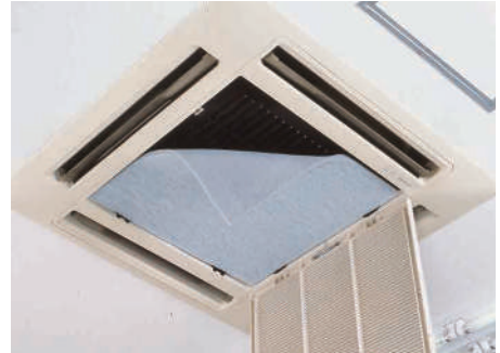
③ 既存のプレフィルターとカバーの間にエアコンマスクを取り付けて完了!
