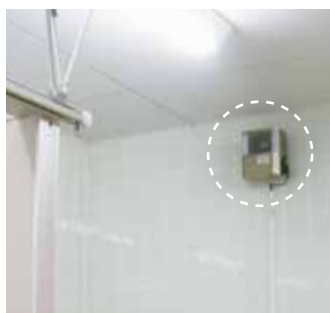
トイレ・汚物処理室
